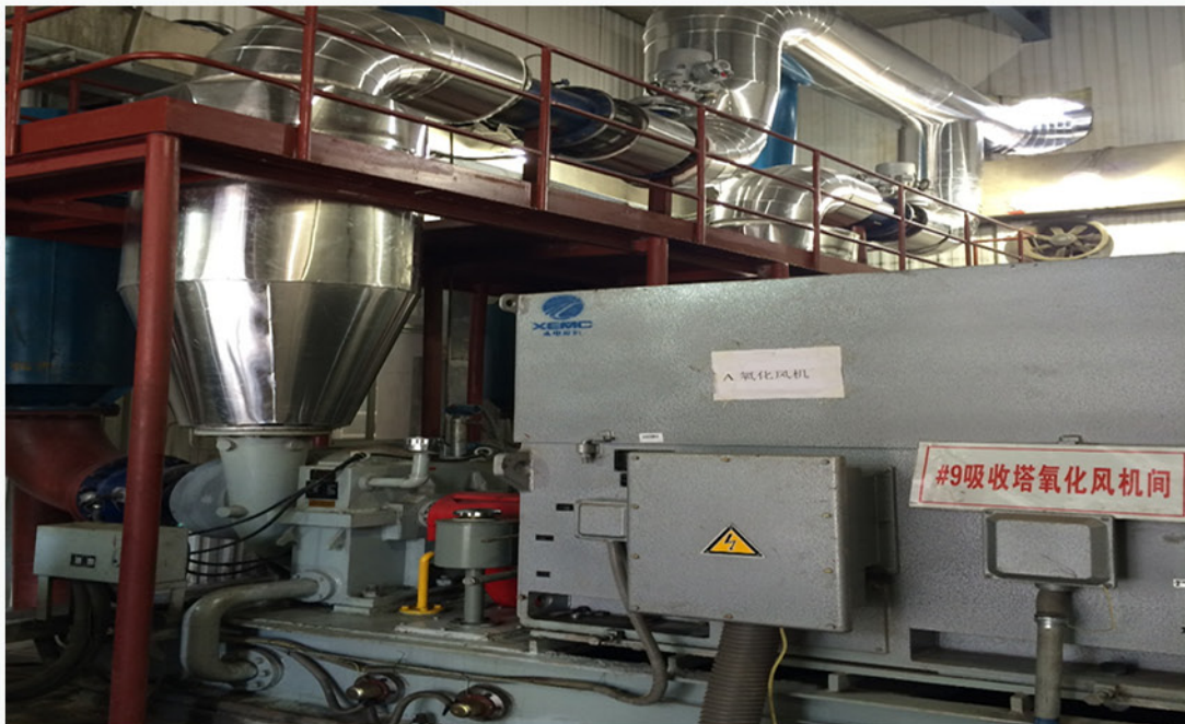
黄台电厂脱硫增容项目
