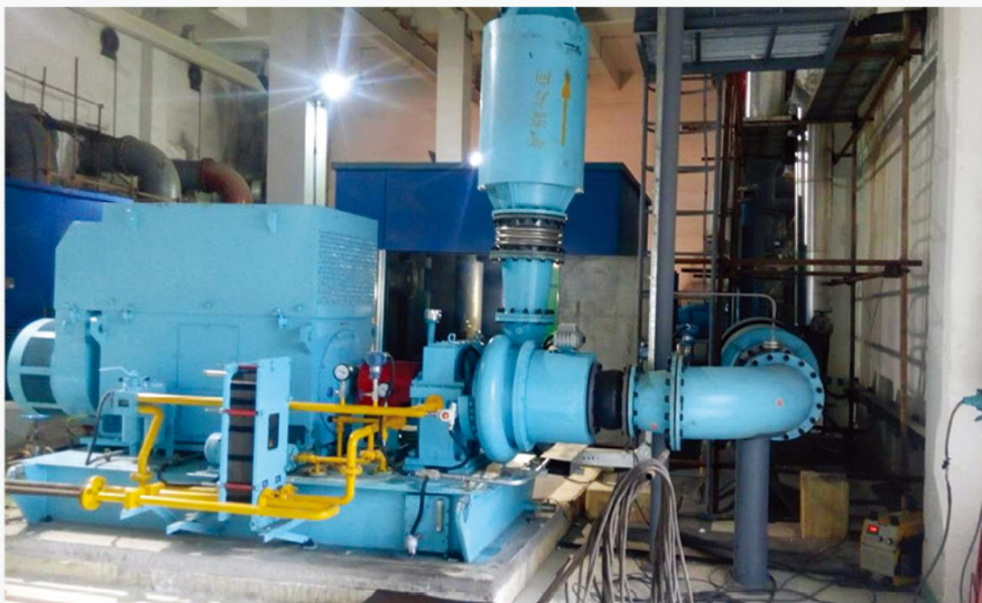
华能瑞金电厂2×350MW脱硫增容改造项目
